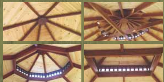
Charpentes de toit / Roof structures
