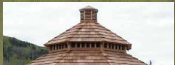
Campanile, coupole et bardeaux de cèdre/cedar shingles
